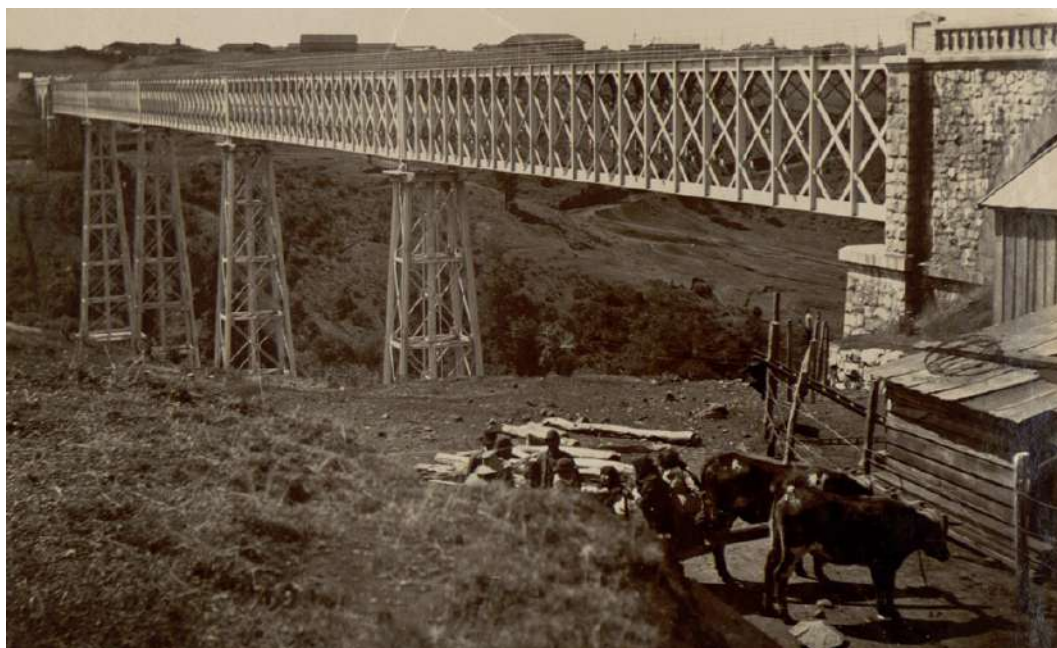
Figura N°4. Puente de Malleco a Collipulli.
